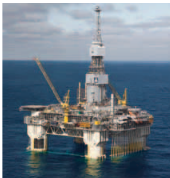
Foto > plattformen Njord A
