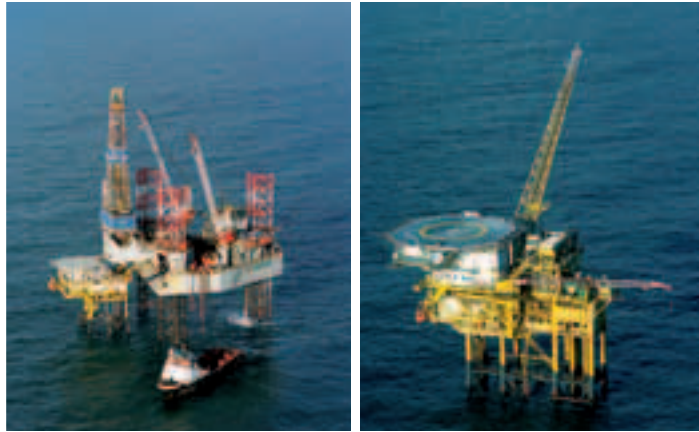
Foto > vänster: workover-rigg över plattformen K6GT > höger: plattform L4A
