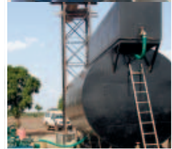
FOTOSEKVENSS INSTALLATION AV EN FILTERSTATION FÖR FÄRSKVATTEN
